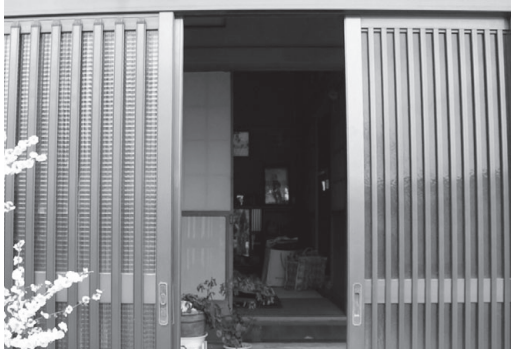
南相馬市内で、福島第一原発から20km圏内にある住宅。窓ガラスが割られ、空き巣が入った形跡が見られた
